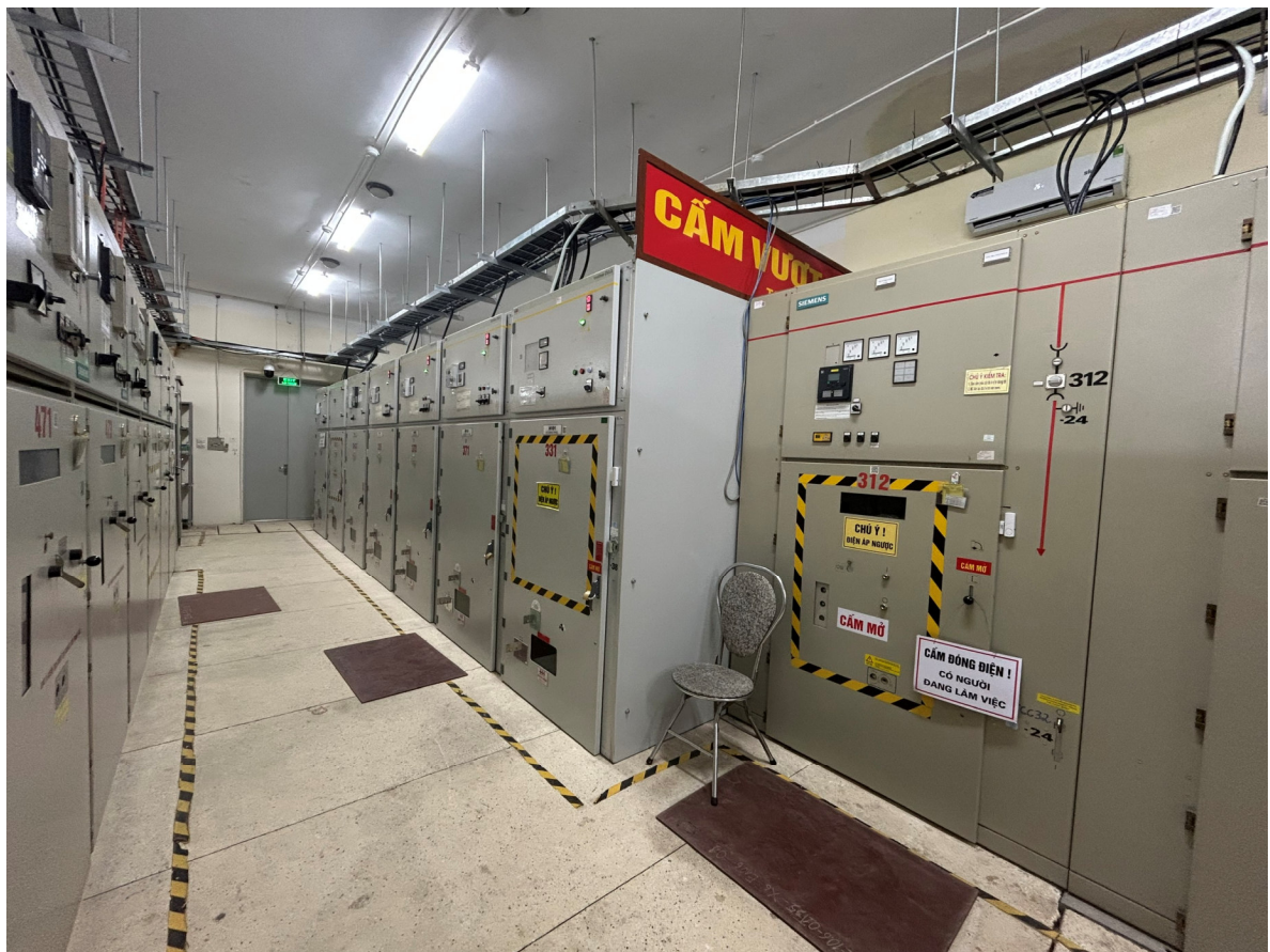
Hình 1. Phòng phân phối 22-35kV
